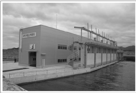
《삼천포화력발전소 내의 해양소수력발전》
